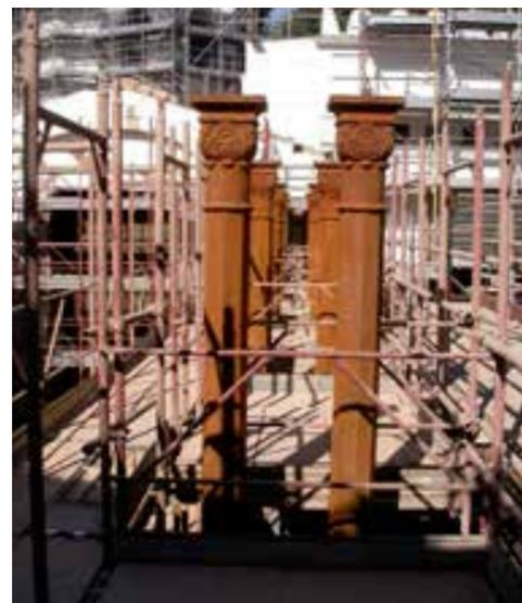
Neri a Roma si è cimentata nel difficile restauro delle grandi strutture, colonne, porte e finestre in acciaio e ghisa, realizzate appositamente per la Serra Moresca voluta dai principi Torlonia. Un luogo ormai distrutto che è tornato a splendere con le sue architetture e le sue vetrate colorate.
