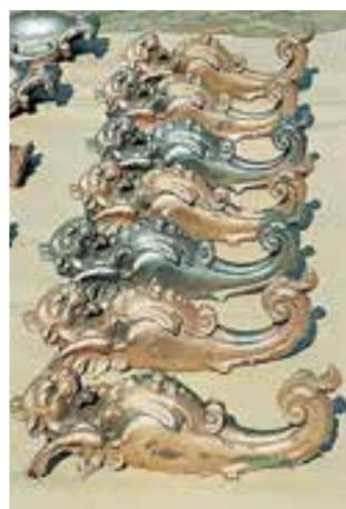
I pali sono stati accuratamente smontati in ogni loro parte; ciascun elemento è stato ripulito e, se in buono stato, riutilizzato per la ricomposizione dei candelabri. In altri casi sono stati realizzati i modelli per la fusione di elementi mancanti o deteriorati.
